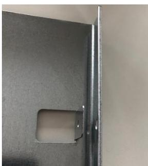
Biegen Sie die am Anschlussprofil die Laschen zur Montage der Gitter auf.
